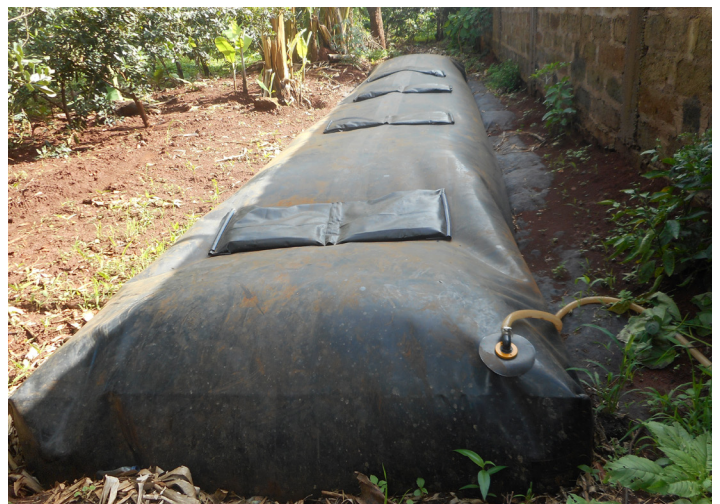
Un biodigestor—un contenedor prefabricado que convierte los residuos agrícolas en abono orgánico y combustible limpio—en la Kenia rural. Fotografía: Root Capital.
